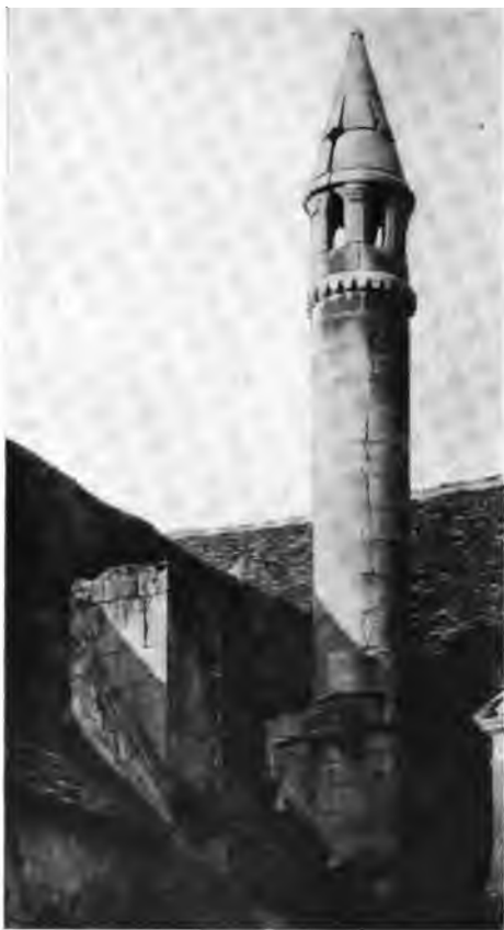
Fig. 120. — Souche de cheminée à l'abbaye de Noirlac (Cher). Protection du conduit cylindrique par une toiture conique.
